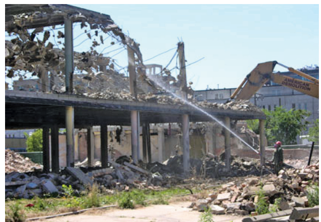
1 pav. Dar neeksploatuoto pastato griovimo darbai
